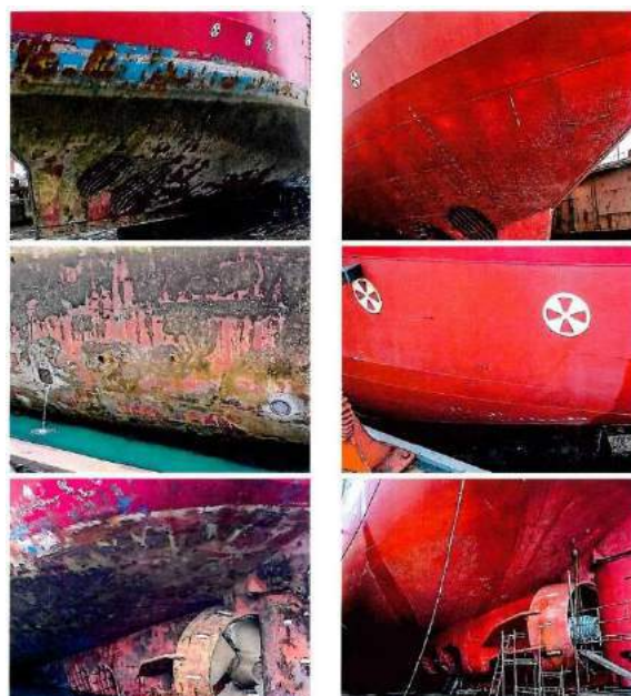
Рис. 2. Состояние корпуса ледокола, окрашенного обычными ледостойкими покрытиями через год эксплуатации в Антарктиде (слева). Состояние корпуса того же ледокола через 4 года эксплуатации в Антарктиде после нанесения Ecospeed (справа).
