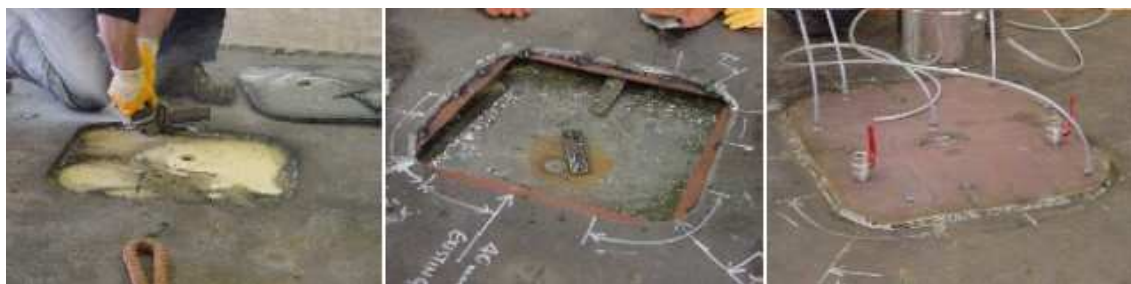
Рис. 4 Устранение дефектов ТП. Слева направо: демонтаж верхнего листа ТП и заполнителя; подготовка кромок и установка опорных полос; монтаж нового верхнего листа ТП
