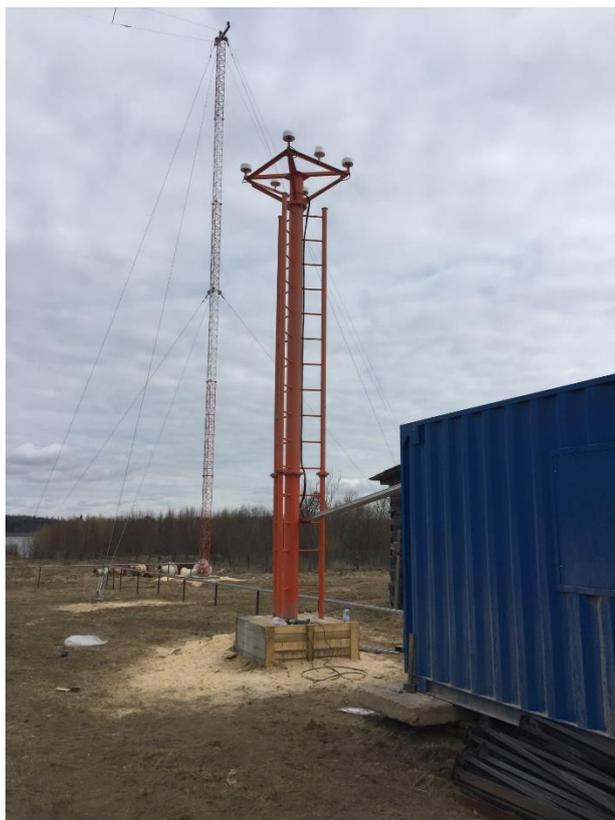
Рисунок 5 – Мачта с оттяжками высотой 30 м для установки Т-образной антенны
