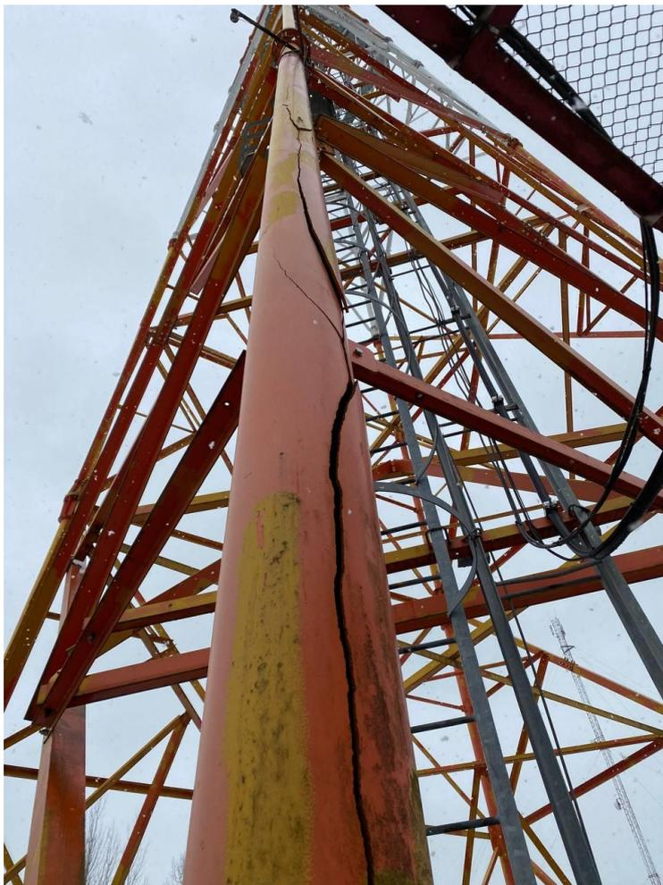
Рисунок 2 – Разрушение опорного пояса башни высотой 90 м в Псковской обл.
